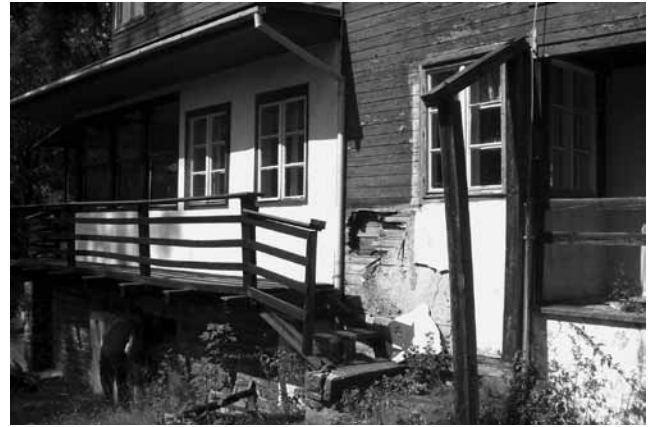
Chátrající exteriér Gajovského vily v r. 2016. Foto Pavel Kašpar, st.
